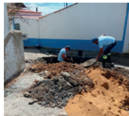
Arranjo de rotura na rede de águas Balurcos e em várias localidades
