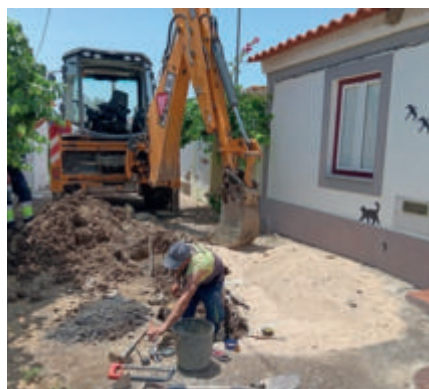
Arranjo de rotura na rede de águas Clarines
