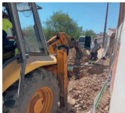
Construção de ramais de água e esgoto Cortes Pereiras
