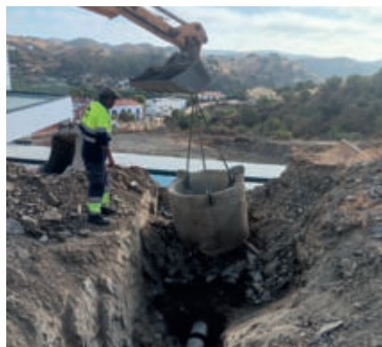
Alteração do ramal de esgoto Alcoutim
