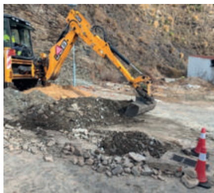
Construção de ramal de águas pluviais Alcútem
