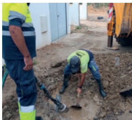
Arranjo de rotura na rede de águas Alcouthim
