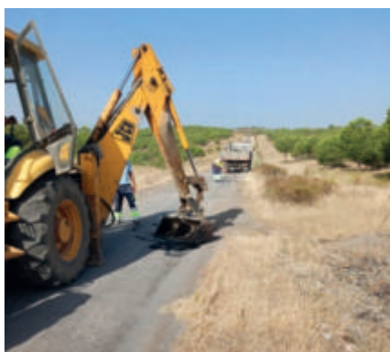
Reparação de pavimento de estradas Corte Tabelião
