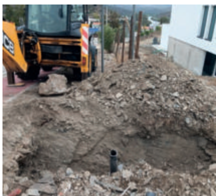
Instalação de válvula de seccionamento na rede de água Alcútem
