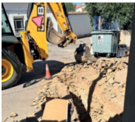
Construção de ramais de água e esgotos Martim Longo
