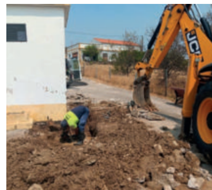
Arranjo de rotura na rede de águas Fonte Zambujo
