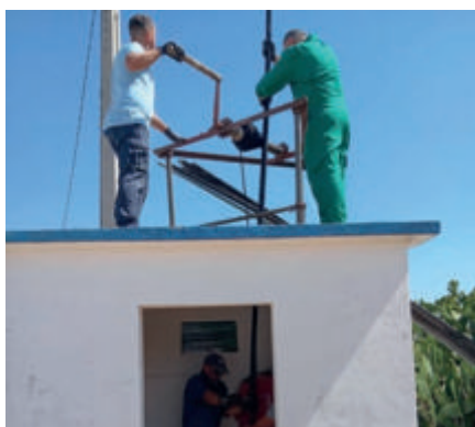
Substituição da bomba de captação subterrânea (furo) Velhas
