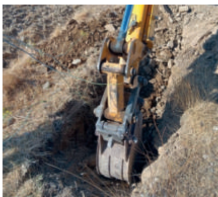
Arranjo de rotura, em conduta adutora Alcaria Cova - Silveira
